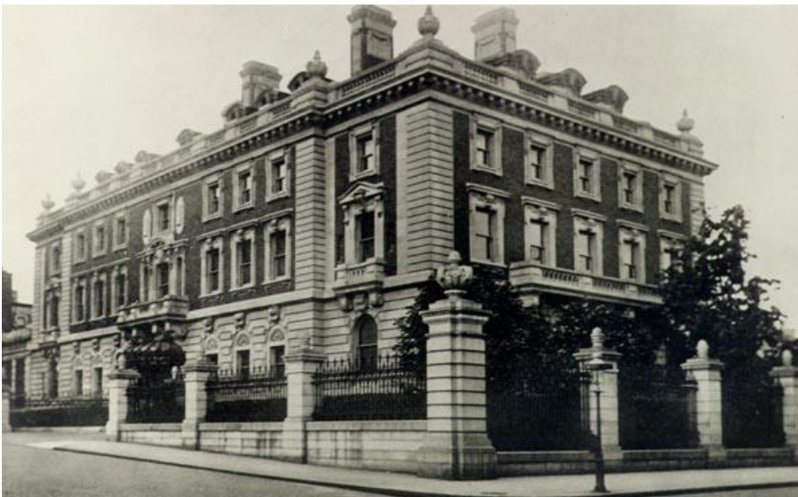
La Villa Carnegie, 5 th avenue, New York
